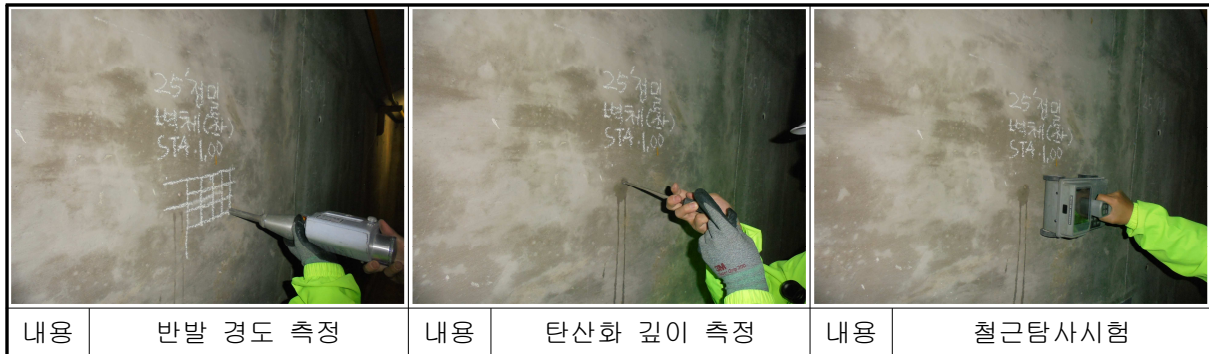
【사진 4.4】 송포일산인출 전력구 재료시험 전경
